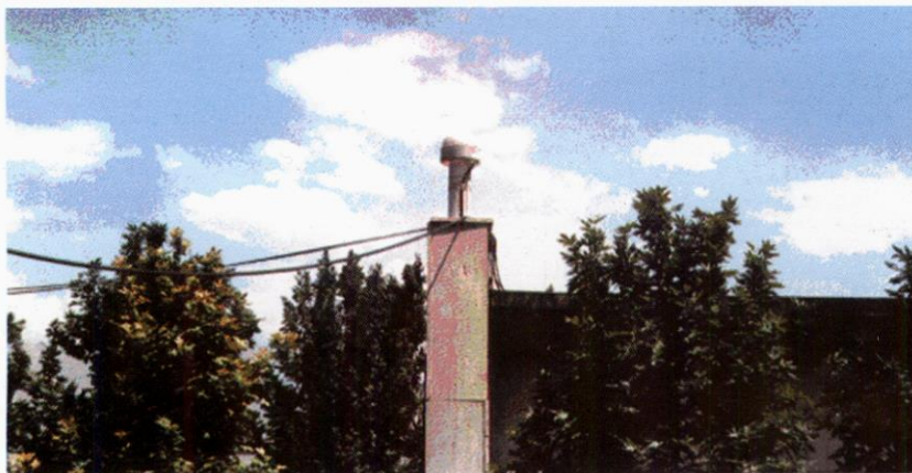
نگاره ۲. ایستگاه دائم GPS تهران که به صورت یک پیلار بتنی بر روی دیوار ضلع شرقی ساختمان مرکزی سازمان نقشه برداری کشور ایجاد شده است.
