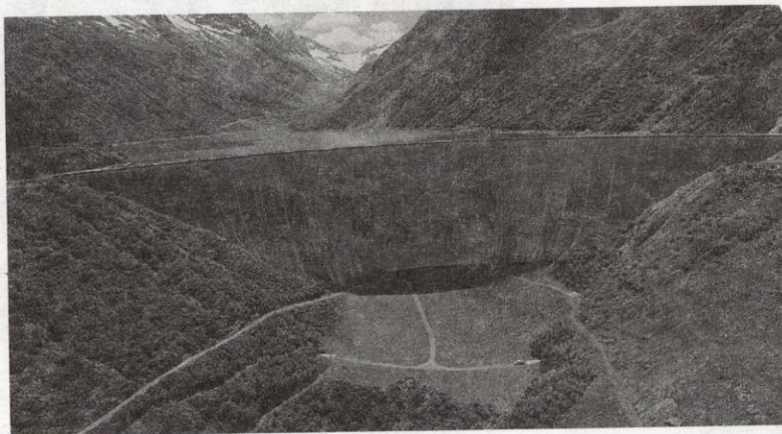
نگاره ۱- دیواره سد مخزنی Nalps (سوئیس). این دیواره با ارتفاع تقریبی ۱۰۰ متر و طول بیش از ۴۰۰ متر ممکن است تا ۸۰ میلی متر جا به جا شود.
