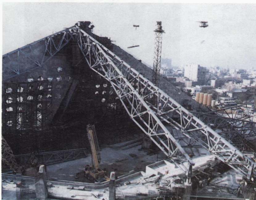
نگاره ۲- خرابای (تیپ ۳) پس از نصب
