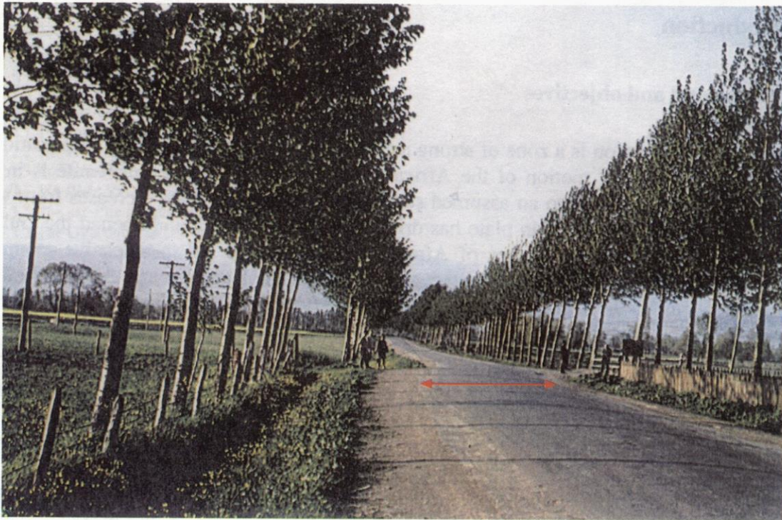
جابجایی پوسته زمین به میزان ۳/۵۰ متر در جهت شرق به غرب ناشی از زلزله کلیم فوریه سال ۱۹۹۴ در ناحیه مرمره
