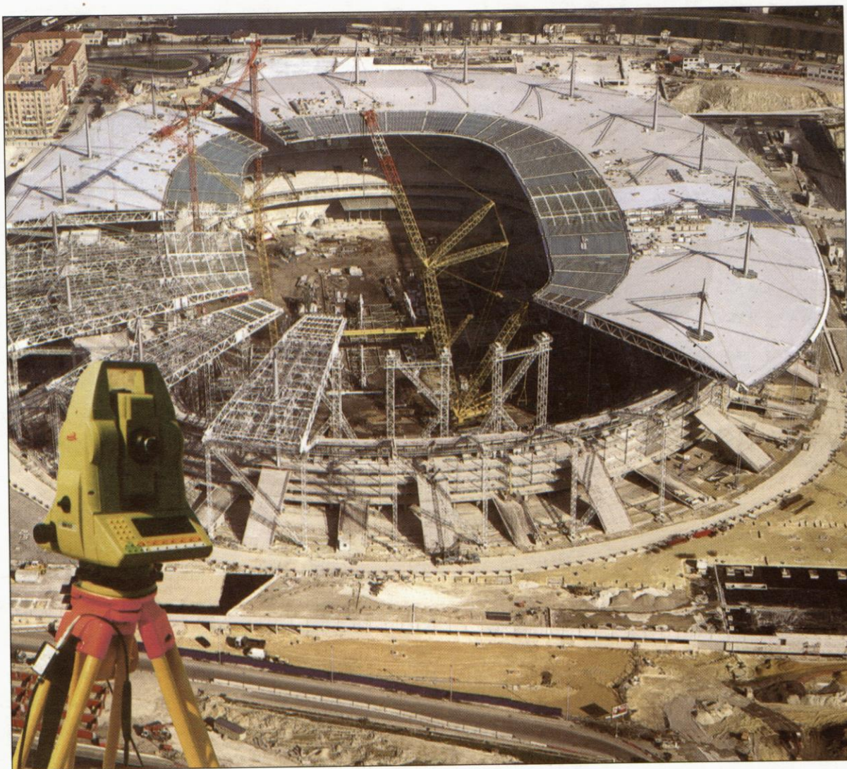
نگاره ۹ - دقت نصب قطعات پیش ساخته در کارگاه ساختمانی استادیوم فرانسه با استفاده از دستگاه های نقشه برداری مدرن ۳ میلی متر بود.
