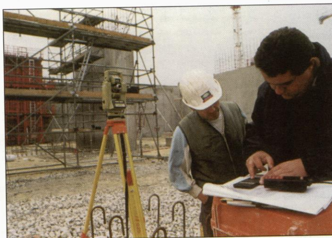
نگاره ۸- تعیین موقعیت دقیق قالب ها به کمک تنودولیت و فاصله یاب لیزری
