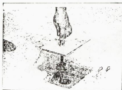
تصویر شماره ۳- با برداشتن قالب بتنی در بالای سطح بتن تعدادی حفره و در مابقی سطوح مدخل استوانه ای بوجود می آید.
