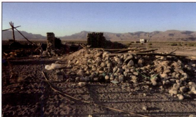
نگاره ۳ - خرابیهای ناشی از زلزله
